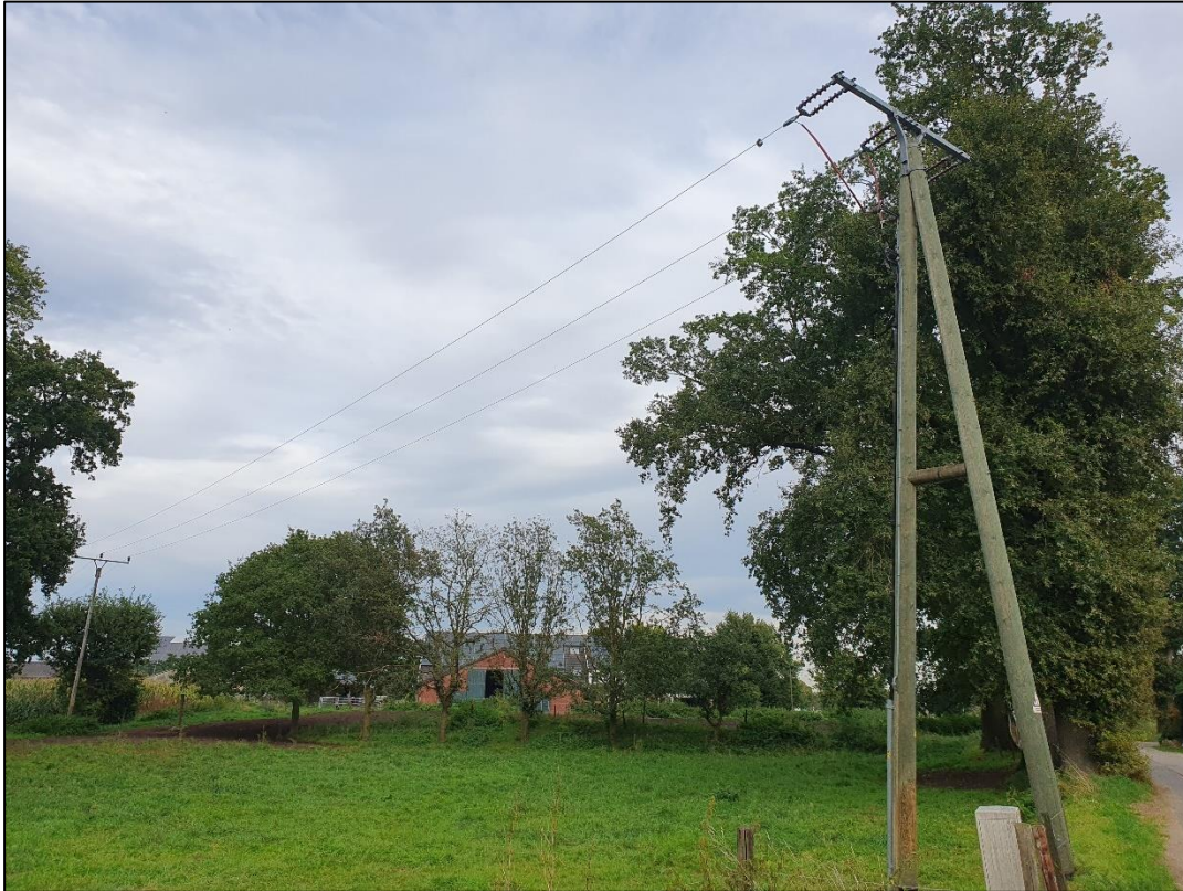
Abbildung 7: Freileitung durchs Plangebiet
