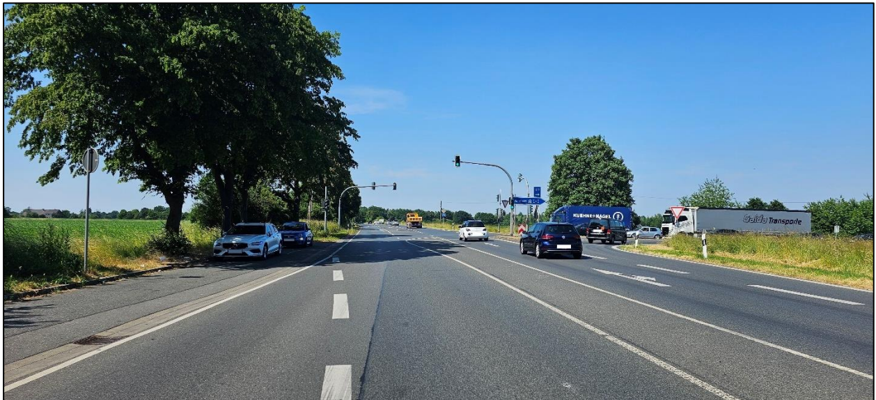
Foto 1: Nördliche Anschlussstelle der A 3 (KP 1) (eigene Aufnahme)
