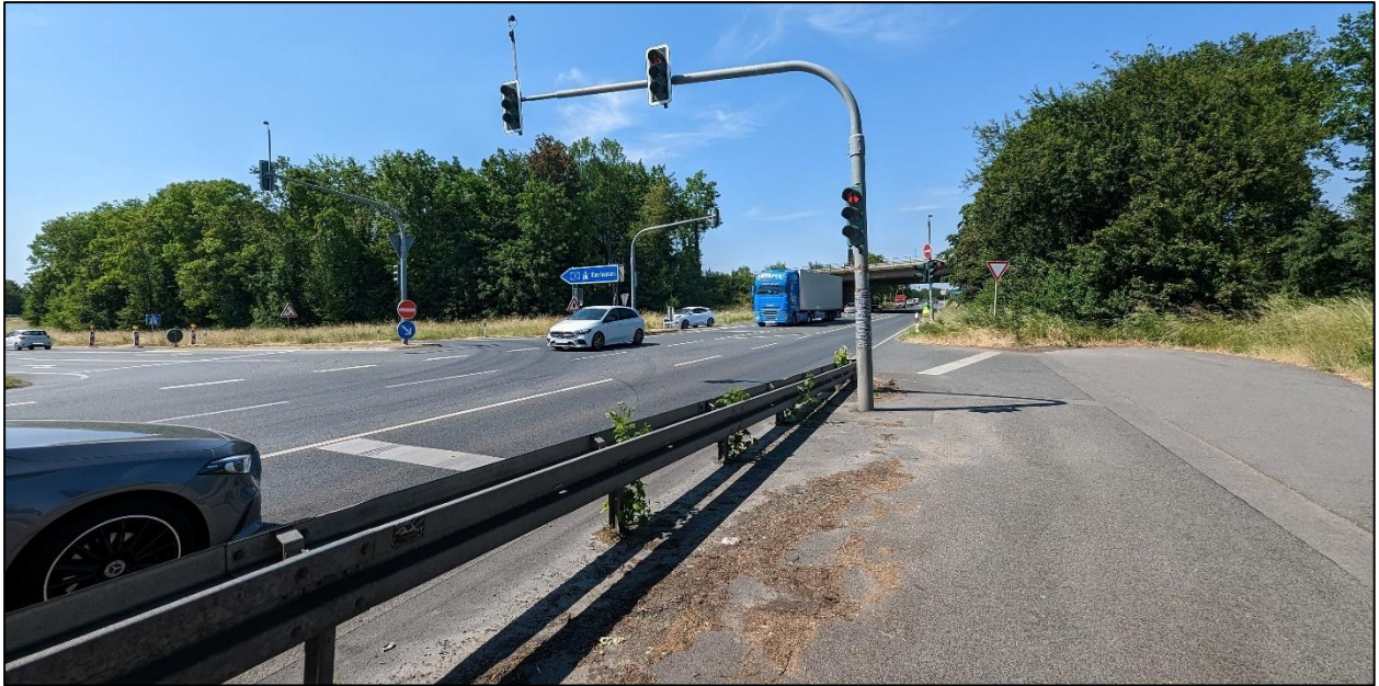
Foto 6: Südliche Anschlussstelle der A 3 (KP 2) (eigene Aufnahme)
