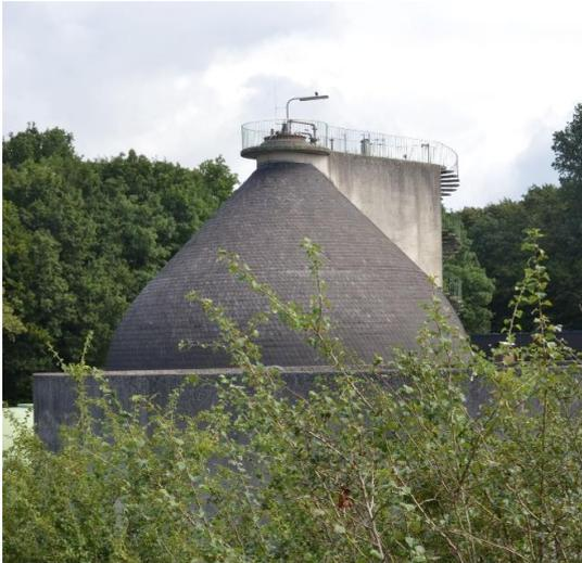
Außerdem befindet sich auf der Kläranlage ein sog. Faulturm, der zur kontrollierten und gesteuerten Durchführung anaerober (sauerstofffreier) Abbauprozesse genutzt wird. Überschüssiger Schlamm aus dem Klärprozess wird abgezogen und dem Schlammfaulbehälter zugeleitet. Der Klärschlamm wird ausgefault, d. h. die organischen Stoffe zersetzen sich. Dies führt zu einer Verringerung der Schlammmenge und einer Verbesserung der Entwässerungseigenschaften.
